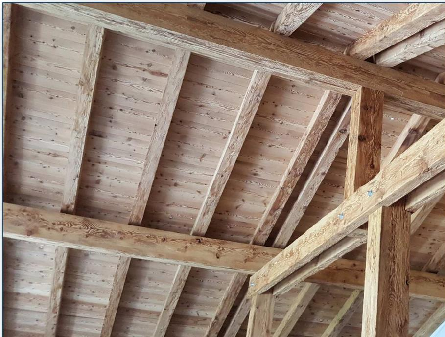
Sur les chevrons apparents, des lames larges en Mélèze étuvé brossé seront clouées, puis viennent un pare vapeur sur toute la surface, l'isolation thermique en mousse de polyuréthane PU, un complément acoustique en fibre de bois ainsi qu'une étanchéité soudée.
