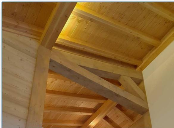
Sur les chevrons apparents, des lames larges en Douglas seront clouées, puis viennent un pare vapeur sur toute la surface, l'isolation thermique en mousse de polyuréthane.
