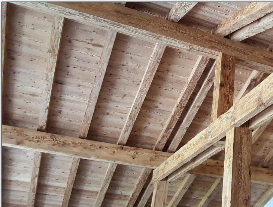
Sur les chevrons apparents, des lames larges en Mélèze étuvé brossé seront clouées, puis viennent un pare vapeur sur toute la surface, l'isolation thermique en mousse de polyuréthane PU ainsi qu'une étanchéité soudée.
